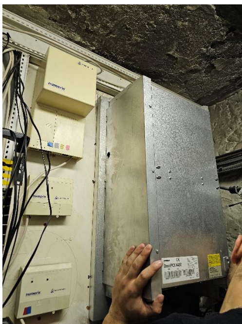
Voici la dépose du PABX, ancien équipement de téléphonie.
